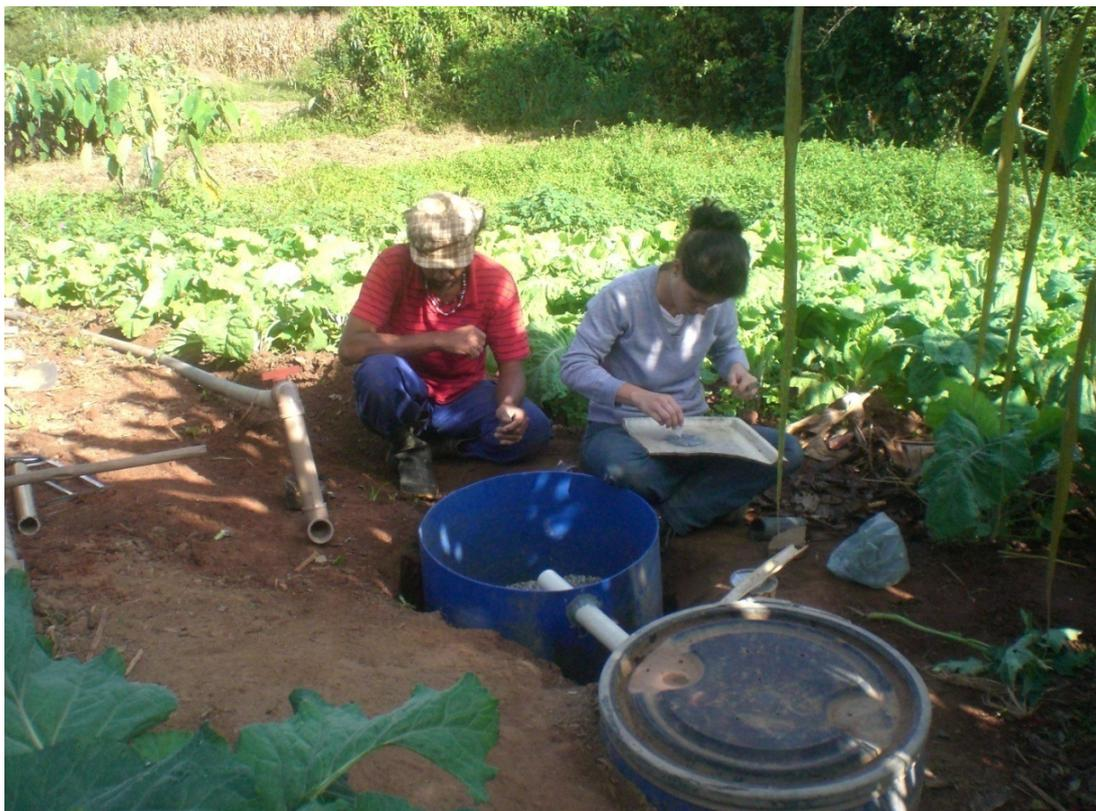
É importante que haja um prolongamento do cano dentro dos tonéis permitindo uma diferenciação de parte da água que fica sem contato com o oxigênio onde há
